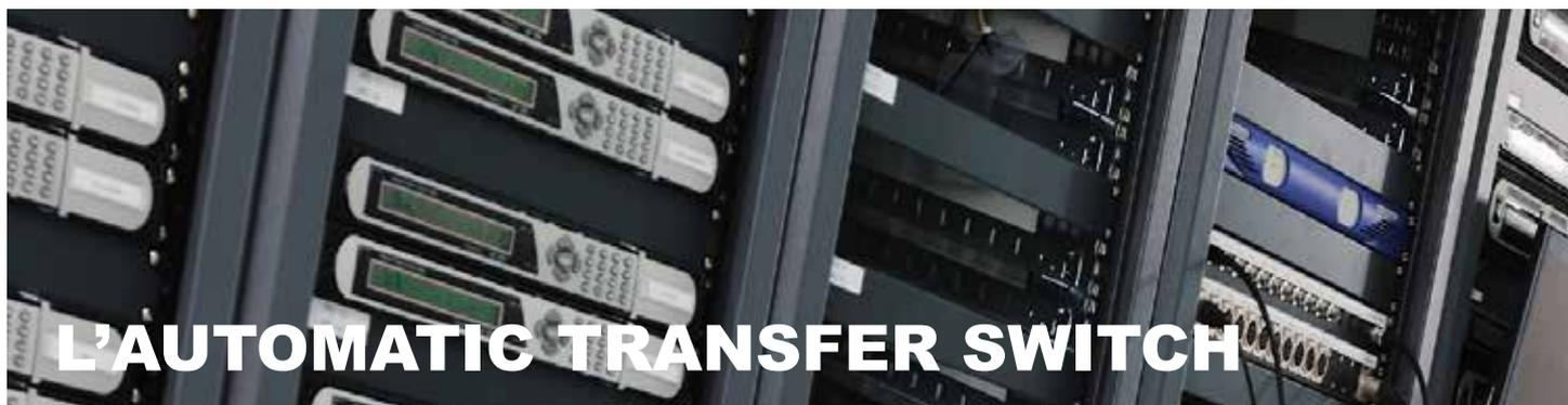
L'ATS permet d'alimenter avec une parfaite redondance les matériels informatiques équipés d'une seule alimentation électrique.
